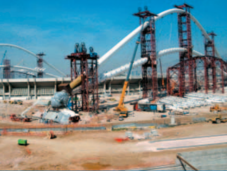
Het Olympisch Stadion in Athene in aanbouw.
